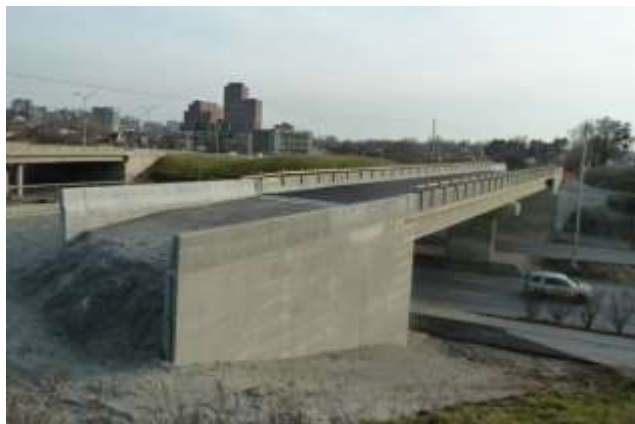
Des Allumettières overpass
